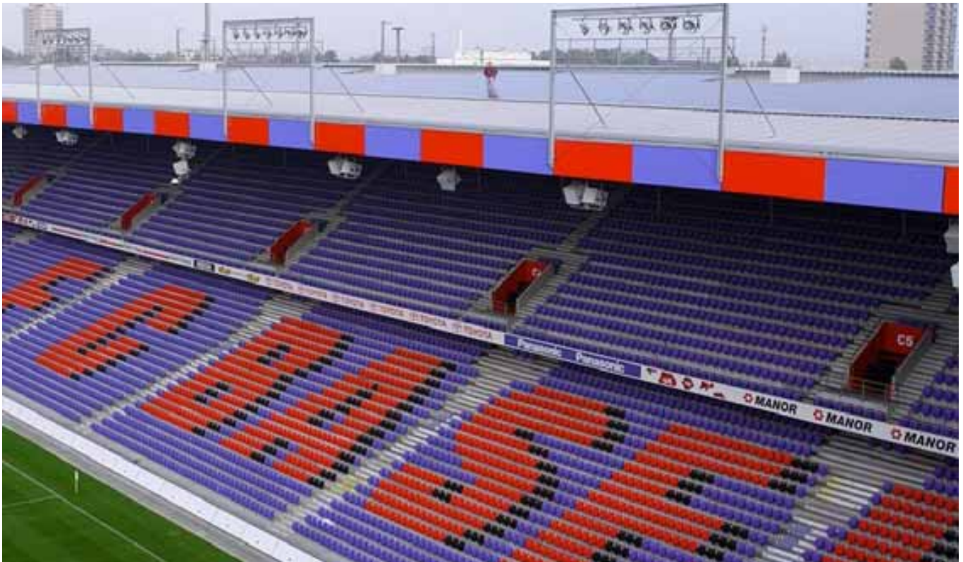
Abbildung 29: Fussballstadion in Basel. Die Photovoltaik-Grossanlage auf dem Basler St. Jakobspark liefert jährlich rund 130 MWh Elektrizität an die Solarstrombörse der Industriellen Werke Basel (IWB). Quelle: energiebüro Zürich
