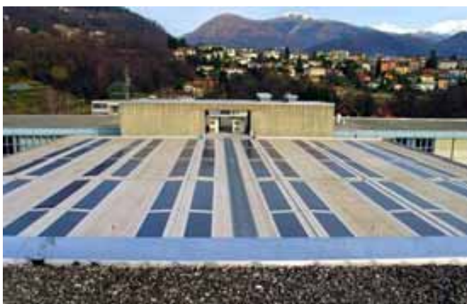
Abbildungen 41 und 42: Innovative Integrationslösungen aus Schweizer Produktion auf den Dächern des Centro Professionale in Trevano (TI) und des Flumroc-Fabrikgebäudes in Flums (SG). Beim Sarnasol Photovoltaik System (Beispiel in Trevano) sind die flexiblen Photovoltaik-Lamine mit der Thermoplast-Kunststoffdichtungsbahn dauerhaft und wasserdicht verschweisst. Eurodach (Beispiel in Flums) heisst die Verbindung von Metallfalzdach und Steinwolle-Wärmedämmung, die sich neu mit Solarelementen kombinieren lässt. Quelle: Sarnafil, Sarnen / NET, St. Ursen
