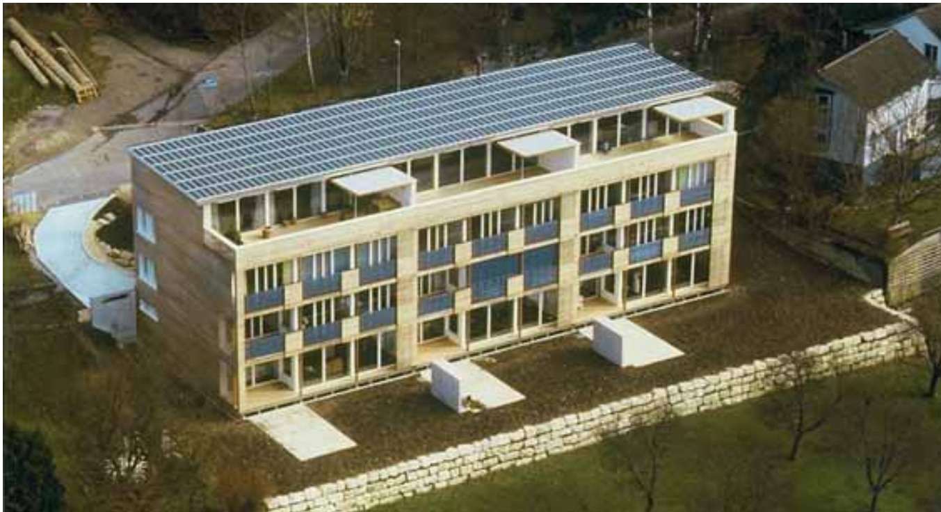
Abbildung 48: Nullheizenergiehaus dank Energieeffizienz und Photovoltaik in Zürich Höngg . Das aus Holz konstruierte Mehrfamilienhaus „Sunny Woods“ ist ein „Nullheizenergiehaus“. Der photovoltaisch erzeugte Strom versorgt die Wärmepumpe für Warmwasser und Heizung. Ein überzeugendes Beispiel für Architektur, Wohnqualität und energetische Optimierung. Quelle: Beat Kämpfen, René Naef, Zürich
