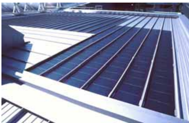
Abbildungen 41 und 42: Innovative Integrationslösungen aus Schweizer Produktion auf den Dächern des Centro Professionale in Trevano (TI) und des Flumroc-Fabrikgebäudes in Flums (SG). Beim Sarnasol Photovoltaik System (Beispiel in Trevano) sind die flexiblen Photovoltaik-Lamine mit der Thermoplast-Kunststoffdichtungsbahn dauerhaft und wasserdicht verschweisst. Eurodach (Beispiel in Flums) heisst die Verbindung von Metallfalzdach und Steinwolle-Wärmedämmung, die sich neu mit Solarelementen kombinieren lässt. Quelle: Sarnafil, Sarnen / NET, St. Ursen
