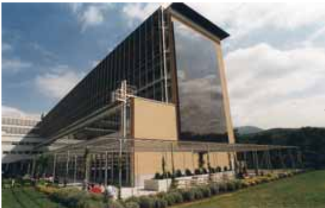
Abbildung 33: Bürogebäude in Manno (TI) mit Photovoltaik im Gesamtenergiekonzept. Der Neubau der UBS wurde in ökologischer und energetischer Hinsicht beispielhaft erstellt. Die Photovoltaikanlage umfasst 183 kW verteilt auf verschiedenen Flächen der Gebäudehülle: 102 kW auf dem Flachdach, 47 kW in der Dachbrüstung (auch als Sonnenschutz) und 34 kW in zwei Südfassaden. Quelle: Enecolo, Mönchaltorf
