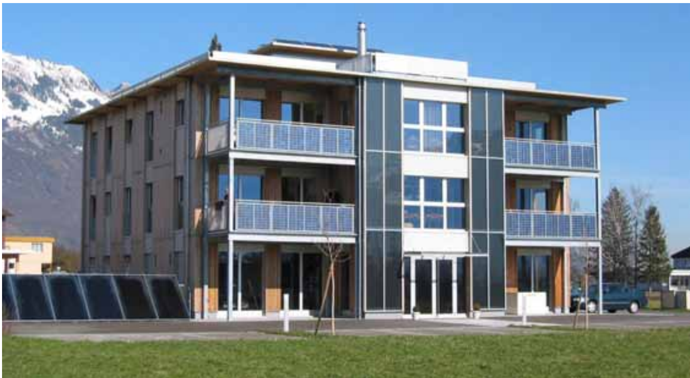
Abbildung 47: Minergie und Photovoltaik in Gams (SG) . Das Minergie Büro- und Gewerbegebäude des Synergieparks hat Photovoltaikmodule in die Fassade / Balkonbrüstung integriert und auf dem Dach mit 25° Neigungswinkel aufgeständert. Quelle: Heizplan / Synergiepark. Info: http://www.synergiepark.ch
