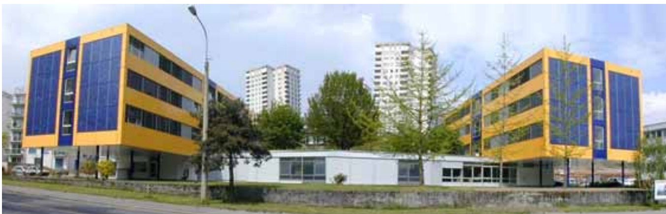
Abbildung 26: Studierendenheim "Rhodanie" in Lausanne . Das Studierendenheim der Fondation Maisons pour étudiants in farblich auffälliger und gefälliger Komposition produziert Solarstrom für die Industriellen Betriebe Lausanne (SIL). Quelle: SIL
