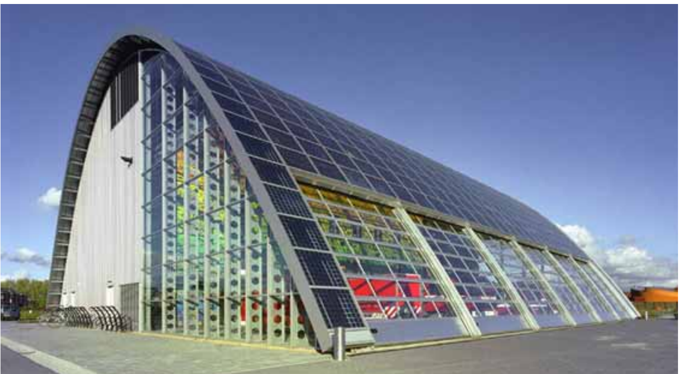
Abbildung 28: Feuerwehrdepot mit progressivem Design in Houten (NL). Das Design hat verschiedene Akteure dazu bewogen, sich beim Projekt (finanziell) zu engagieren. Quelle: Samyn & Partners / R. Schropp, Niederlande
