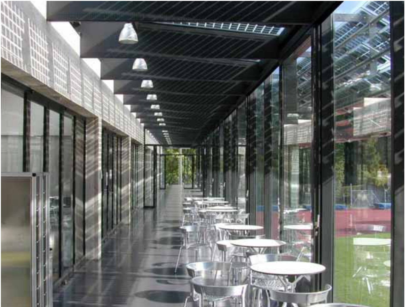
Abbildung 18: Kantonsschule in Stadelhofen (ZH) . Semitransparente Solarmodule in Dach und Fassade erlauben es, sowohl mit Licht und Technik wie auch mit Gebäude und Umgebung kunstvoll umzugehen. Solararchitektur heisst hier die Kombination von natürlichem Tageslicht für die Räume, Verschattung gegen Überhitzung und Stromproduktion. Nebst der hohen Funktionalität bietet sie eine angenehme Atmosphäre, die beispielsweise auch öffentliche Aufenthaltsräumen und Eingangshallen aufwerten. Quelle: NET, St. Ursen
