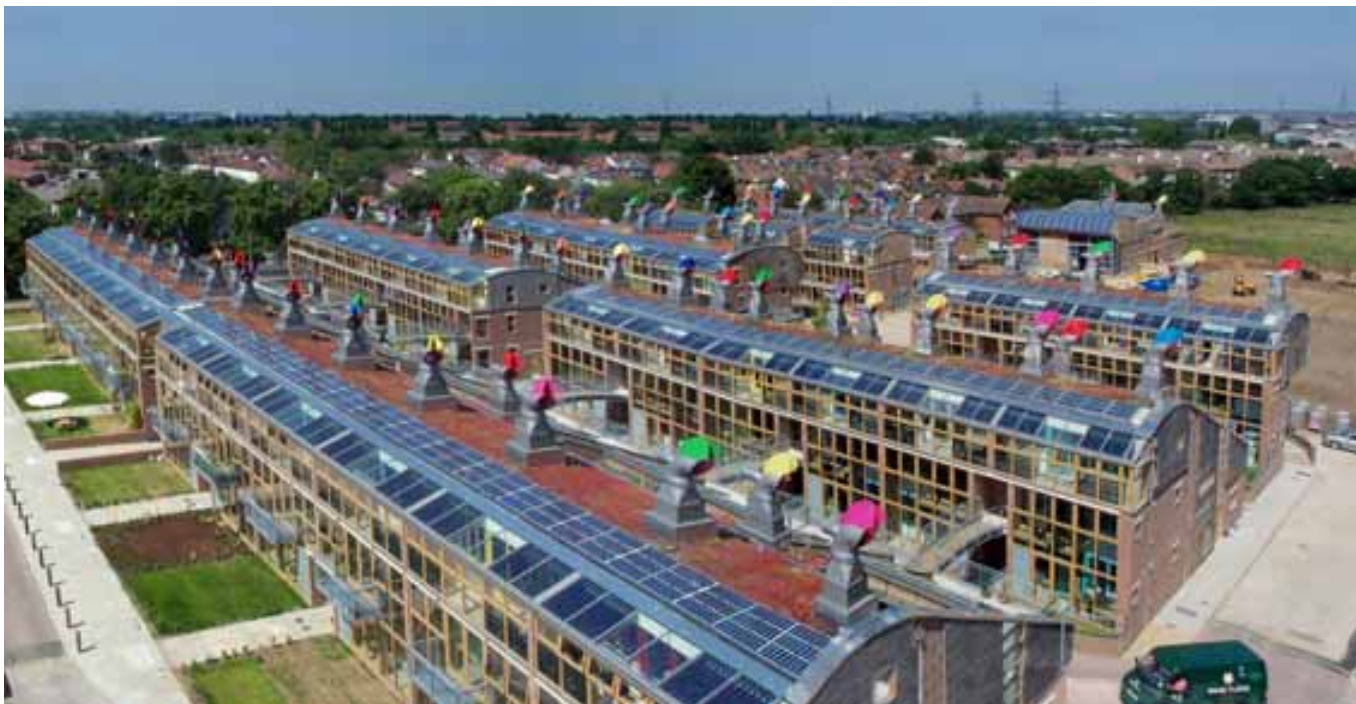
Abbildung 62: Wohnen und Arbeiten in solaren Apartments in Beddington (GB). Nullfossilenergiehäuser für Wohnen und Arbeiten in Einem. Die Siedlung mit einer ersten Tranche von 82 Einheiten baut auf ein innovatives Energiekonzept mit Photovoltaik. Photovoltaik liefert vor Ort wertvollen Strom und dient zugleich als Verkaufsargument. Die Apartments sind gebaut für die wachsende Anzahl Menschen, die von zuhause aus arbeiten. Quelle: Bill Dunster Architects
