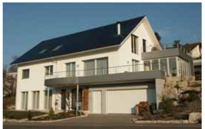
Abbildung 36: Einfamilienhaus in Untersiggenthal (AG) mit flächendeckender Photovoltaikanlage. Die Stromproduktion der Photovoltaikanlage liegt auf Jahresbasis rund 15% über dem gesamten Energiebedarf des Einfamilienhauses (inkl. Heizung und Warmwasser). Quelle: G. Erni, Untersiggenthal
