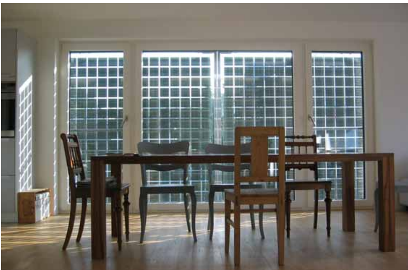
Abbildungen 37 und 38: Innovatives Design mit Passivhaustechnologie und Photovoltaik in Pratteln (BL) . Aussen- und Innenansicht des Gebäudes mit solaren Fensterläden im Blickfeld. Die verschiedenen Photovoltaikmodule des Einfamilienhauses weisen eine Gesamtleistung von 3,1 kW auf. Quelle: R. Miloni, Mülligen
