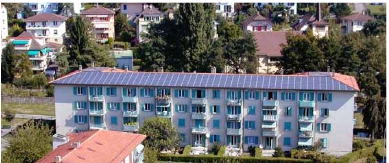
Abbildung 30: Mehrfamilienhaus in Lausanne. Die Solaranlage (38 kW) leistet einen Beitrag zur Nachhaltigkeit und vermittelt zugleich einen Hauch Exklusivität - Argumente, die bei (potenziellen) MieterInnen zählen. Der Solarstrom wird an der Solarstrombörse der Services Industriels de Lausanne (SIL) gehandelt. Die Stadt Lausanne hat die Installation zusätzlich finanziell unterstützt. Bau und Betrieb der Anlage erfolgen durch Contracting mit Edison Power. Quelle: NET, St. Ursen
