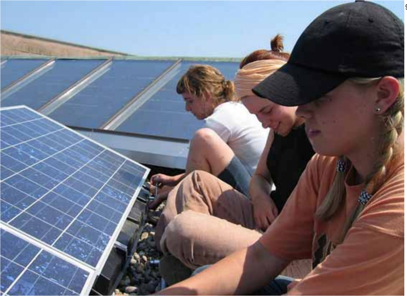
Abbildung 23: SchülerInnen bringen eine Solarstromanlage auf das Seminar Kreuzlingen (TG). Nadin Bill hat in ihrer Diplomarbeit Nachhaltiges geschaffen: Sie hat ein Solarprojekt initiiert und durchgeführt, inkl. Sicherung der Finanzierung. Die Anlage mit 10,2 kWp Leistung steht auf der Turnhalle. Quelle: N. Bill, Kreuzlingen
