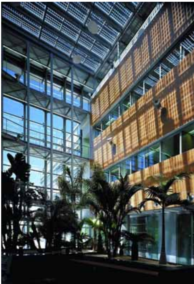
Abbildung 39: Lichtdurchflutete Halle bei STMicroelectronics in Plan-les-Ouates (GE). Die semitransparente Photovoltaikanlage erzeugt Solarstrom und ein angenehmes Ambiente. Quelle: AMA Group / Engeco Synergies, Italien
