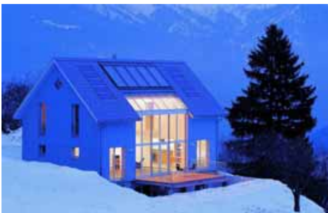
Abbildung 35: Typenhaus im Minergiestandard mit Photovoltaik und thermischer Solaranlage in Malix (GR). Quelle: ARTHAUS Raum und Linie Rhäzüns
