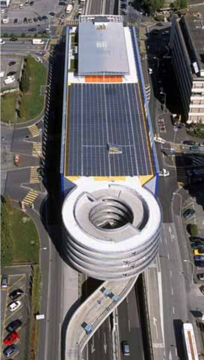
Abbildung 31: Parkhaus in Genf. Das fünfstöckige Parkhaus (Park&Ride Etoile) in der Stadt Genf ist mit einer grösseren Photovoltaikanlage versehen worden. Das halboffene Photovoltaikdach weist eine installierte Leistung von 143 kW auf, der Strom wird in das Netz der Services Industriels de Genève (SIG) eingespeist. Quelle: Sunwatt Bio Energie, Chêne-Bourg
